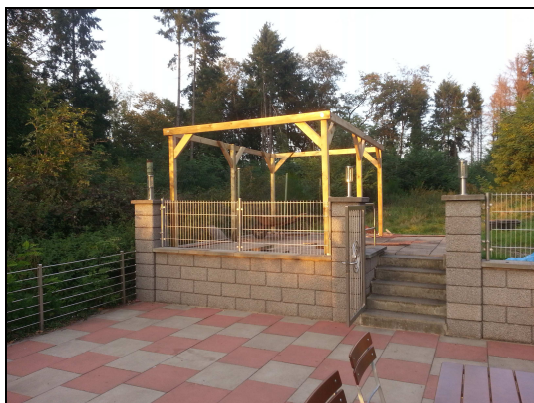
Grundgerüst auf dem Grillplatz
